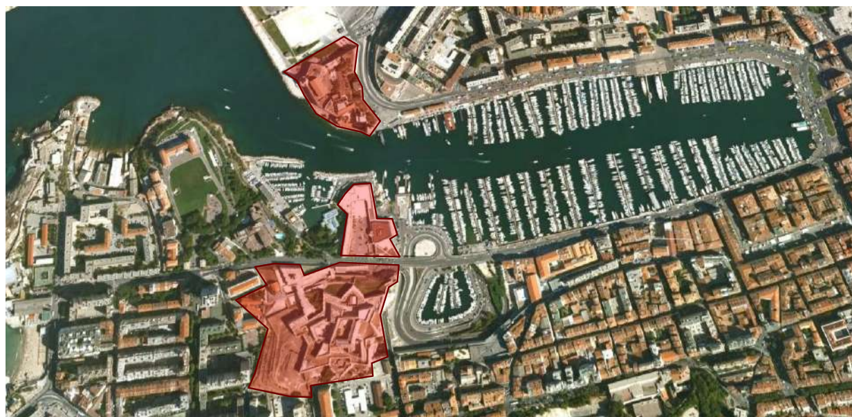
La citadelle St-Nicolas et le fort St Jean, par leur emprise, structurent fortement l'entrée dans le port.
