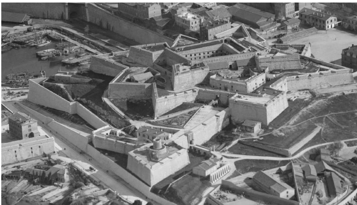
1920 Vue aérienne du fort d'Entrecasteaux (Document IGN – Site « Remonter le temps »)
