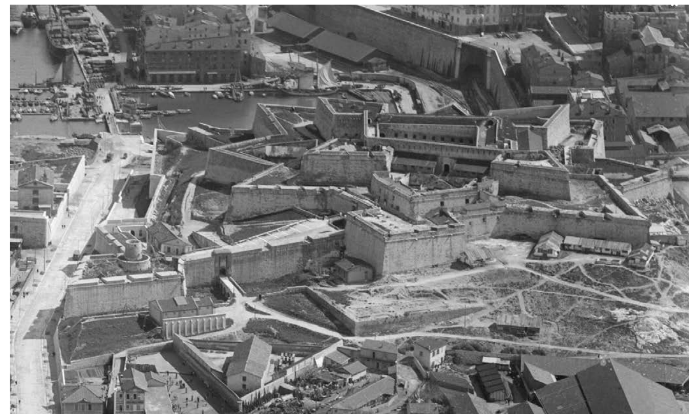
1928 Vue aérienne du fort d'Entrecasteaux (Document IGN – Site « Remonter le temps »)
