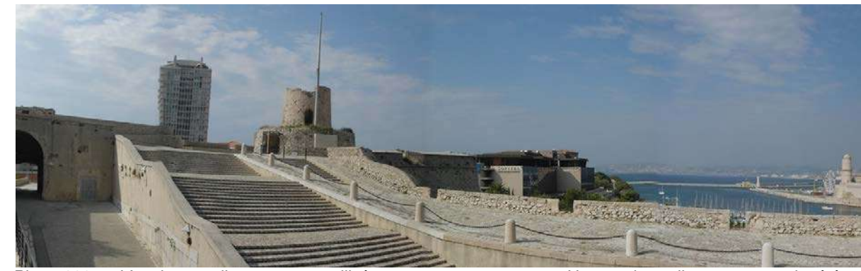
Photo 2005 – L'ancien moulin est encore utilisé en monument aux morts. Un grand escalier monumental a été bâti sur les décombres de l'ancienne chapelle.
