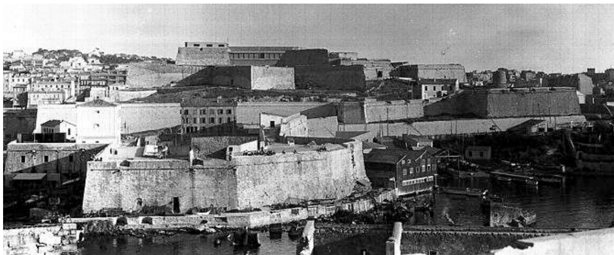
Photo années 50. Le toit en béton armé construit par l'armée allemande est encore présent sur le bastion du Roy, ainsi que le haut mur construit avant guerre par l'armée française entre les bastions Mazarin et du Roy. (AM)
