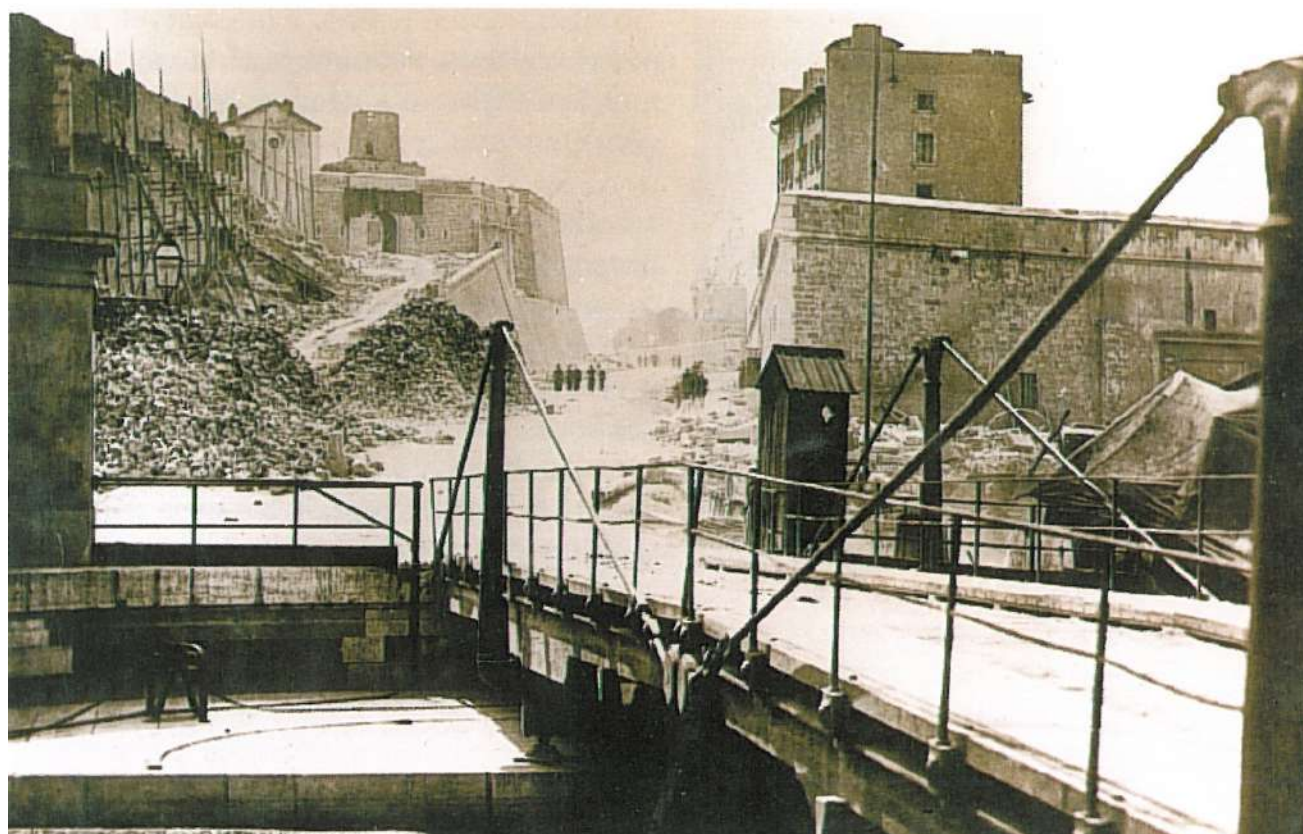
Percement du boulevard Charles Livon (Cl.Baudelaire – Photo Detaille)
