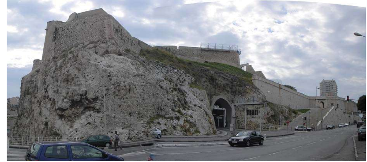
Photo 2005 - La bretelle d'accès au tunnel sous le Vieux-Port a été réalisée, le tunnel St Maurice a été percé, le mur de soutènement bâti lors de la percée du boulevard a été démoli, le rocher creusé. Une rampe plus raide bordée d'un large escalier donne l'accès au fort d'Entrecasteaux.
