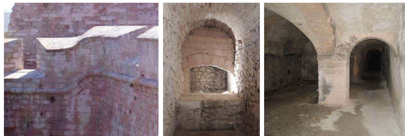
Pierre de la Couronne rose, briques en terre cuite, moellons de pierre froide et chaux ont été essentiellement utilisés pour bâtir la citadelle.
